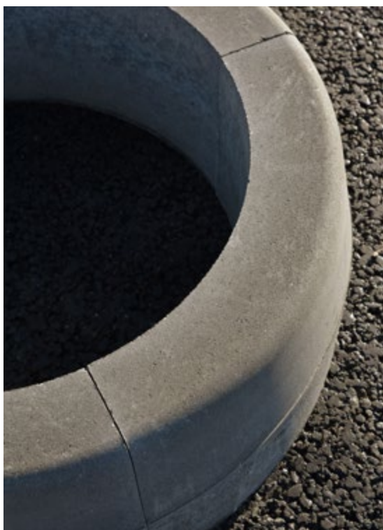
Окружность R=0,5 м из камней дорожных радиусных
